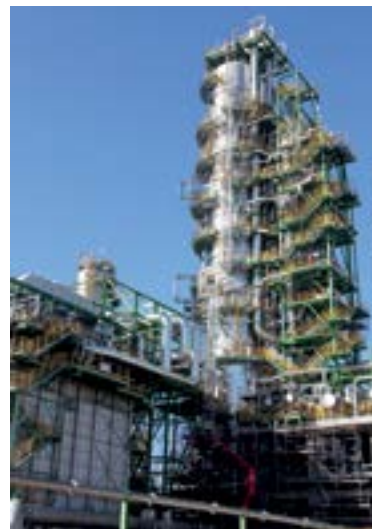
Своевременное завершение механико-монтажных работ вакуумной колонны высотой 71 м и общим весом 760 тонн в ходе останова.
