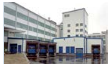
Строительство здания новой смесительной установки, включая сливо-наливную автомобильную эстакаду, длилось шесть месяцев
