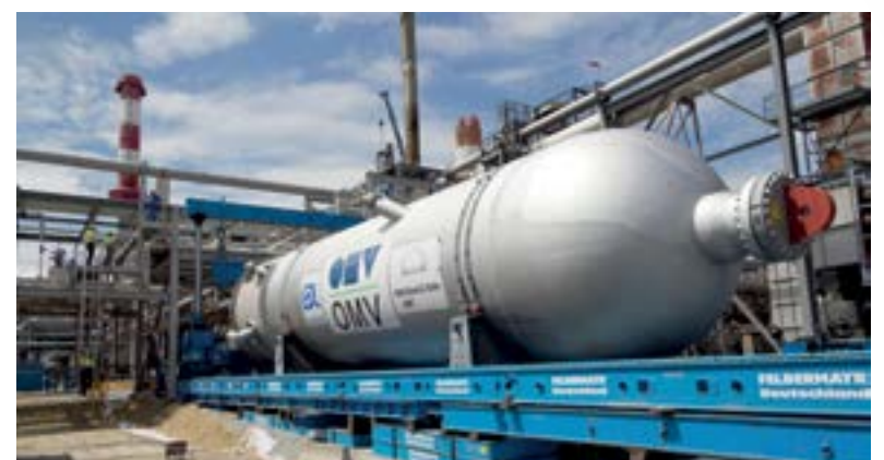
С зазором всего 8 см реактор был перемещен на гидравлическом скользящем устройстве под трубной эстакадой.
