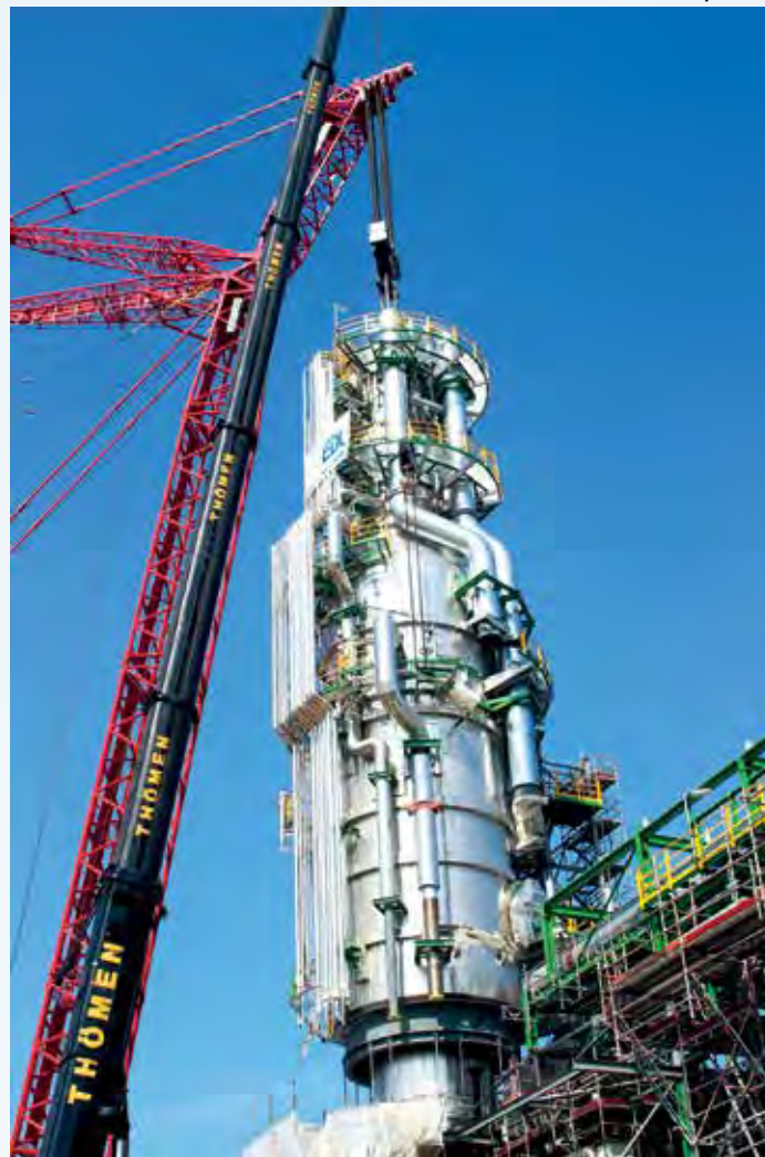
Установка колонны VT3, 2013г.
