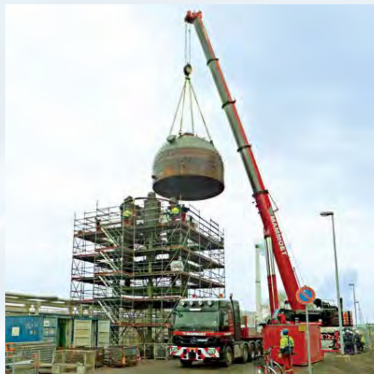
Подъем крышки корпуса реактора FCC «Medusa», 2014г.
