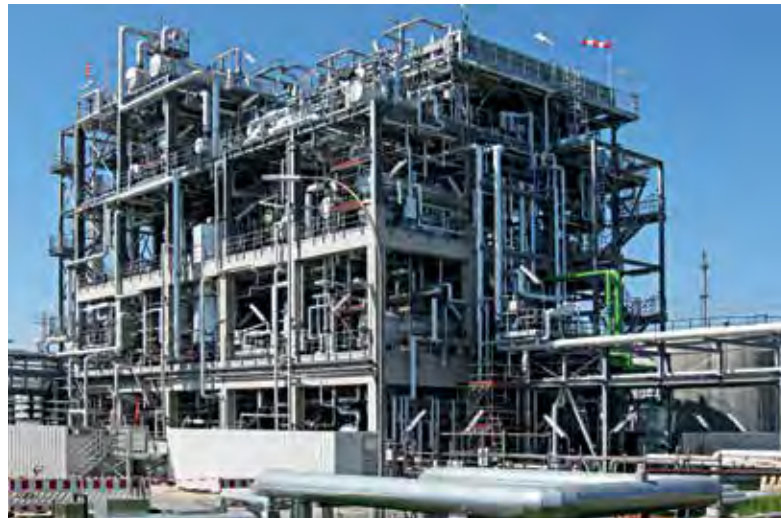
Многие данные о технологических параметрах были заимствованы из опыта строительства установки деасфальтизации пропаном на масляном заводе H&R Ölwerke Schindler в Германии.
