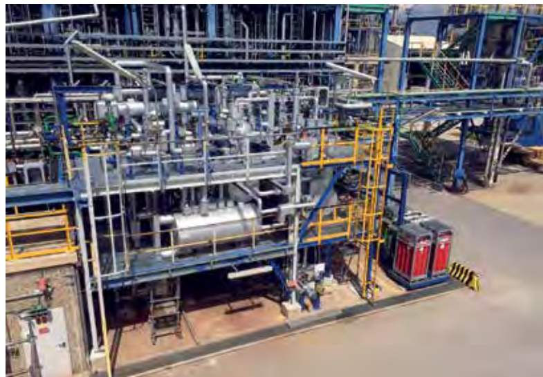
Проведена модернизация секции рекуперации на установке RP2, введенной в эксплуатацию на 2 недели раньше установленного срока.
