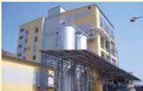
Polyester- und Alkydharz-Anlage für Spolchemie in Usti nad Labem/Tschechien, 2006
