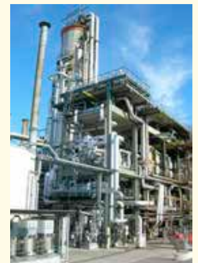
RD4-Anlage für OMV in Schwechat, Österreich, 2010
