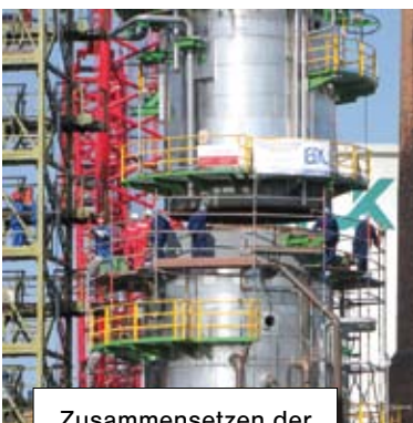
Zusammensetzen der Kolonnenteile - alles funktioniert nach Plan
