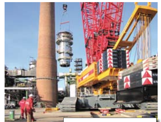
Die Größenverhältnisse erstaunen auch erfahrene Baustellenarbeiter
