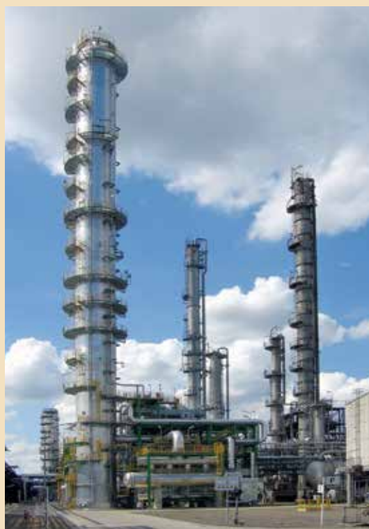
C 3 сплиттер-колонна на "РСК" г. Шведт, выполненная с компрессией пара, ребойлером/конденсатором, оборудованными трубами UOP-HIGHFLUX
