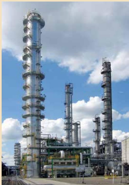
C<sub>3</sub>-Splitter im PCK Schwedt, ausgeführt mit Brüdenkompression, Reboiler/Kondensator, ausgestattet mit UOP-HIGHFLUX-Rohren
