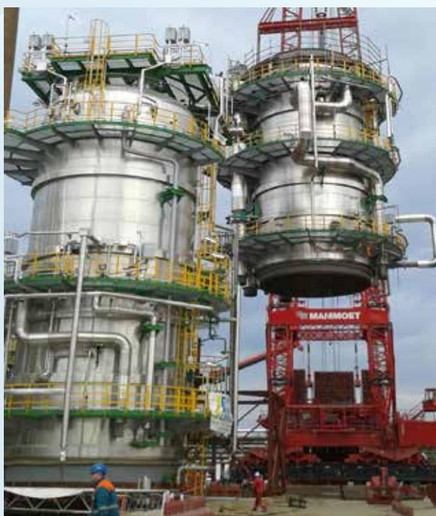
Einheben des Mittelteils der Vakuumkolonne 1K6
