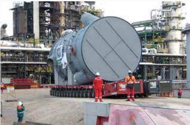
Transport eines Regeneratorteils (16 m lang, Ø 9,5 m) über die Behelfsüberfahrt
