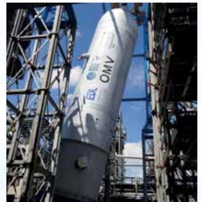
Ein erhebendes Erlebnis: der neue HDS3-Reaktor wird aufgerichtet und ohne Nachjustierung auf das Fundament gesetzt.
