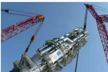
Hub der Vakuumkolonne der VT3-Anlage, PCK Raffinerie GmbH, Deutschland
