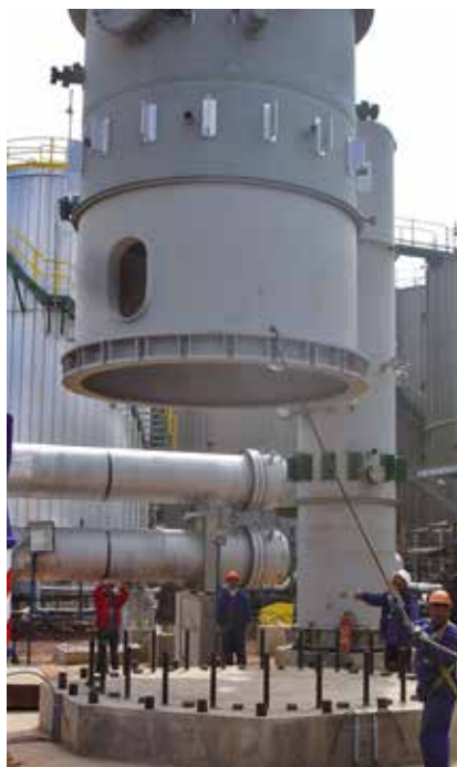
Установка Biturox® SAMIR, Марокко, 2011 г.
