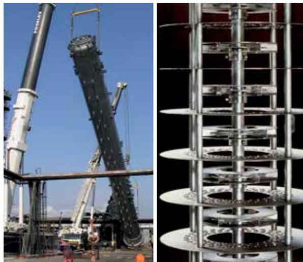
Рис. 3 Экстракционная колонна с внутренними устройствами с мешалкой ф. Зульцер, слева), высокоэффективные, внутренние устройства колонны с мешалкой ф. Зульцер (справа)
