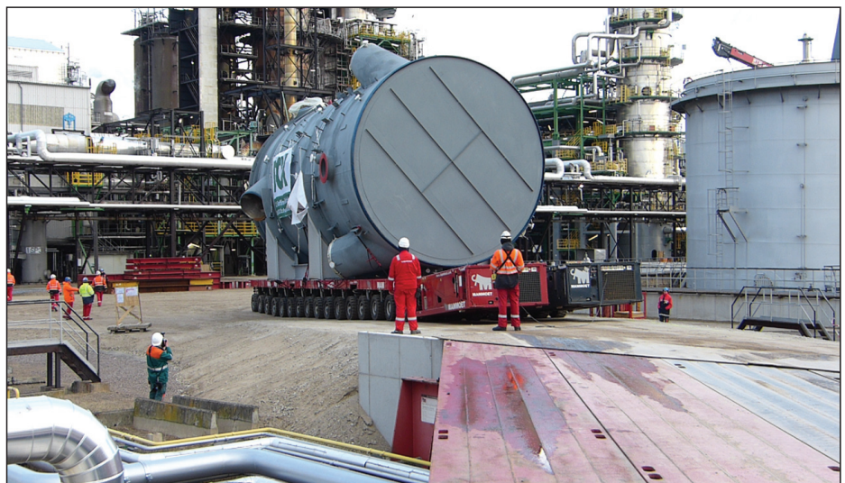
Transport eines Regeneratormoduls über die Behelfsüberfahrt
