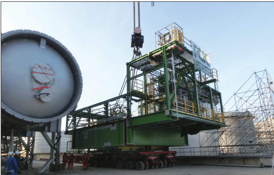
Vormontierter Regeneratortisch mit einem Gewicht von 168 t
