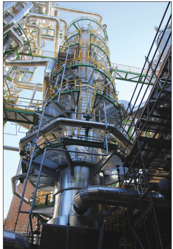
Bereits montierte Stripperkolonne 1K3 in der Rohöl1-Anlage
