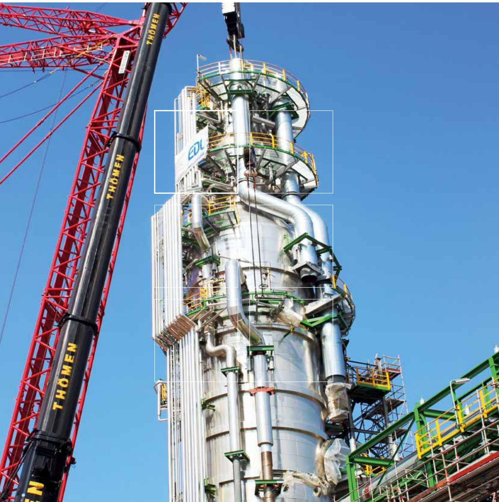
Модернизация установки вакуумной перегонки VT3
