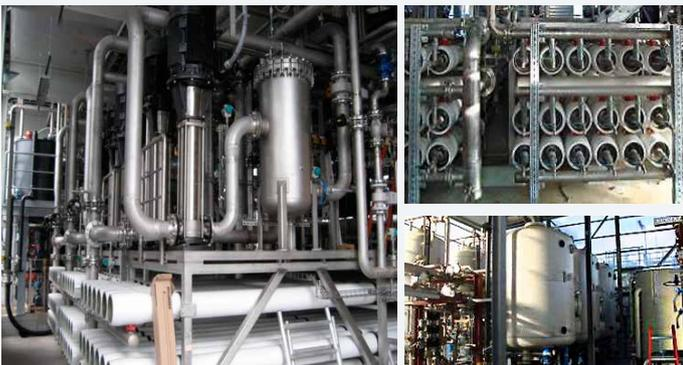
Очистка воды для питания котлов с применением технологий ультрафильтрации, катионитового фильтра для декарбонизации, обратного осмоса, дегазаторов и многоступенчатых ионообменных фильтров производительностью 300 м<sup>3</sup>/ч (1-й этап) и 100 м<sup>3</sup>/ч (2-й этап).
