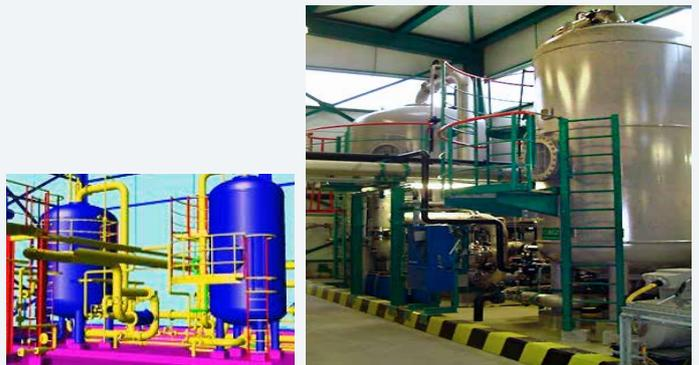
Подготовка питательной воды для котлов с применением катионита, дегазаторов, анионита и фильтра смешанного действия. Производительность ионообменника составила 180 м<sup>3</sup>/ч, расход фильтра смешанного действия - 360 м<sup>3</sup>/ч.
