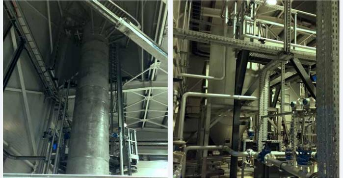
Поставка и ввод в эксплуатацию системы очистки речной воды методом коагуляции, флокуляции, осаждения и процессом дегазации для повторной закачки в нефтяное месторождение. Производительность - 33 м<sup>3</sup>/ч (5 000 баррелей в сутки).
