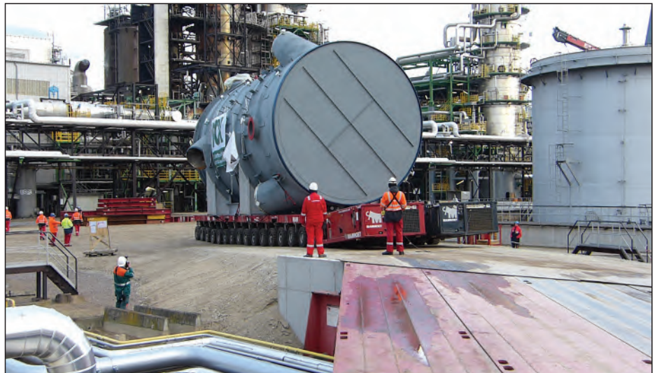
Transport eines Regeneratormoduls über die Behelfsüberfahrt
