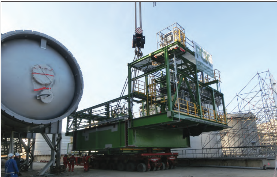
Vormontierter Regeneratortisch mit einem Gewicht von 168 t
