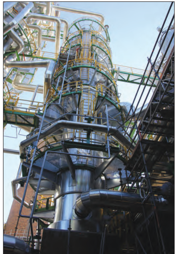
Bereits montierte Stripperkolonne 1K3 in der Rohöl1-Anlage
