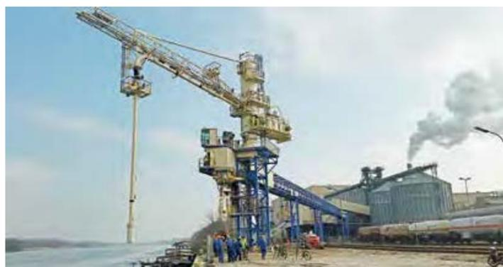
Mit dem 30 m hohen Kran und 22 m langen Förderarm können 300 t Rohstoffe pro Stunde entladen, beziehungsweise ebenso viele Tonnen Industrieprodukte geladen werden.
