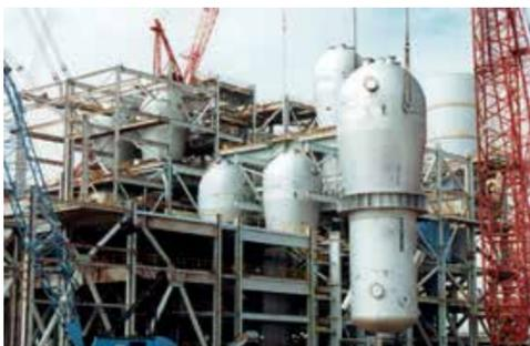
genkomponenten, Reaktoren, Behälter, Fördereinrichtungen und Rohrleitungen hängen an einem 100 Meter hohen Stahlgerüst. Der Pörner Auftrag umfasste die Berechnung der 16 Reaktoren nach Australischer Norm sowie 17 unterschiedliche Apparate und zirka 20 Rohrleitungssysteme.
