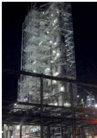
sechs Kolonnen, drei Behälter und ein Verdichter umgebaut, sowie 20 Pumpen, neun Wärmetauscher und drei Wärmetauscherbündel ausgetauscht. Rund 400 Rohrleitungen sind zum Teil neu verlegt worden, wodurch zirka 200 Einbindungen in den Rohrleitungsbestand notwendig waren. In Zuge der mechanischen Änderungen sind zirka 400 neue Mess- und Regelungstechnikgeräte installiert worden. Für die fristge-
