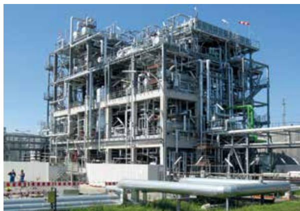
Рис. 1 Установка деасфальтизации пропаном, H&R Ölwerke Schindler GmbH, Гамбург, Германия
