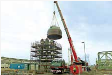
Подъём купола реактора FCC, Total Raffinerie Mitteldeutschland GmbH, Германия
