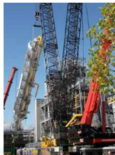
Установка HyLube II, Puralube GmbH, г. Эльстерауэ / Германия
