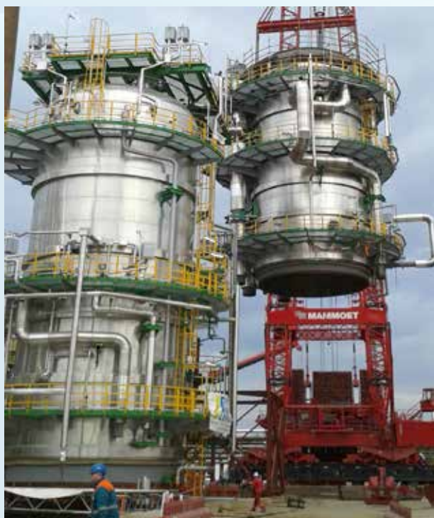
Подъём средней части вакуумной колонны 1К6
