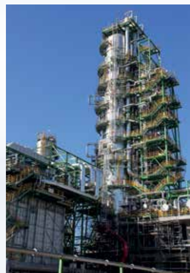
Монтаж модуля колонны 1К6
