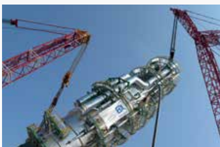
Подъём вакуумной колонны установки VT3, PCK Raffinerie GmbH, Германия
