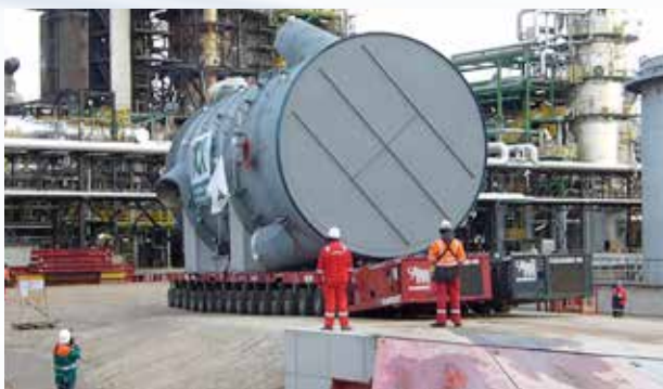
Транспортировка части регенератора (длина 16 м, диаметр 9,5 м) по временным мосткам
