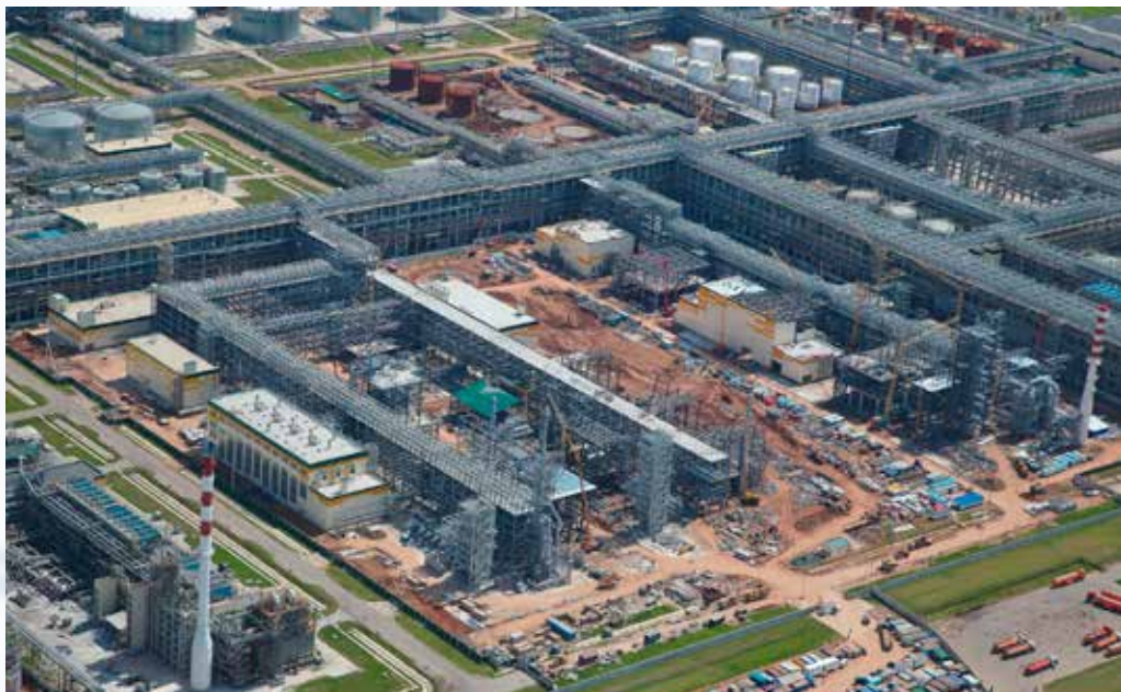
В настоящее время полным ходом идут строительные и монтажные работы на двух установках гидроочистки Комплекса нефтеперерабатывающих и нефтехимических заводов в Нижнекамске
