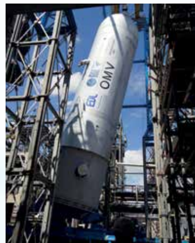
Торжественный момент: новый реактор HDS3 вертикально поднят и установлен без дополнительной подгонки.
